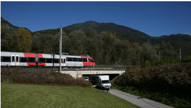
Süd-Ansicht der Enterbachbrücke (Feld III)
