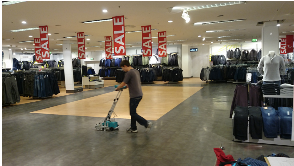
Abb. 9 Feuchtescan im Kellergeschoss eines Kaufhauses
