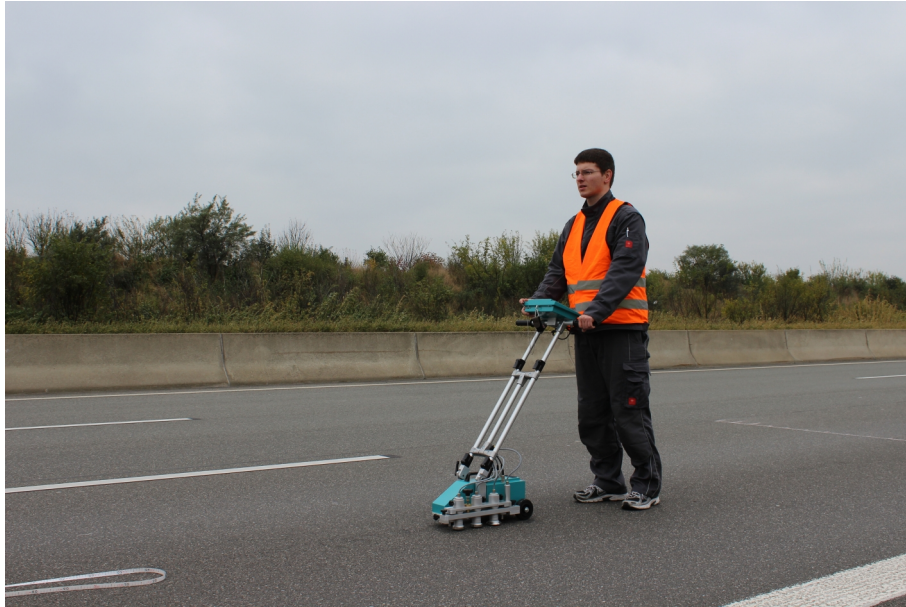
Abb. 6 Feuchtescan über alle Fahrbahnen einer Autobahn
