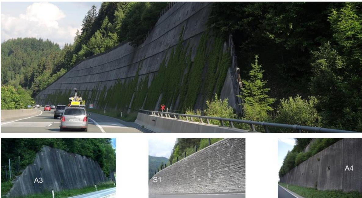
**Abb. 12.** Stützmauern im österreichischen Straßennetz und Aufnahme mit einer mobilen Messplattform
