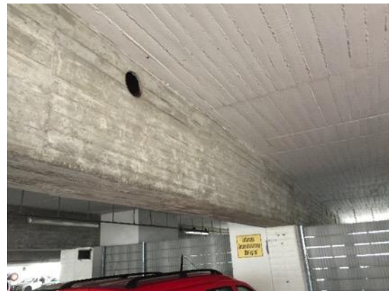
Abb. 11: Spannbetonbinder über Parkhausebene, Spanngliedführung in nachträglich verpressten Hüllrohren
