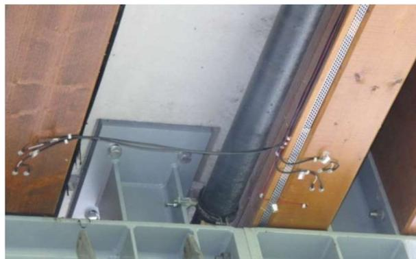
Abb. 5. Zwei Messbereiche über dem Fluss an der Unterseite der Fahrbahnplatte (links) und dem Zugband des Bogens (rechts).
