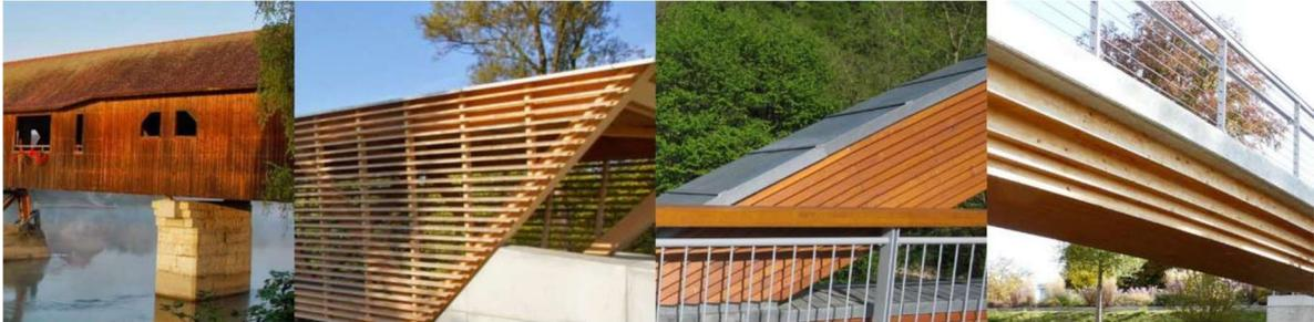
**Abb. 1.** Beispiele für konstruktive Schutzmaßnahmen - Dach, Einhausung, Verkleidung, Blechabdeckung, Dachüberstand und Holz- Beton- Verbundkonstruktion.
