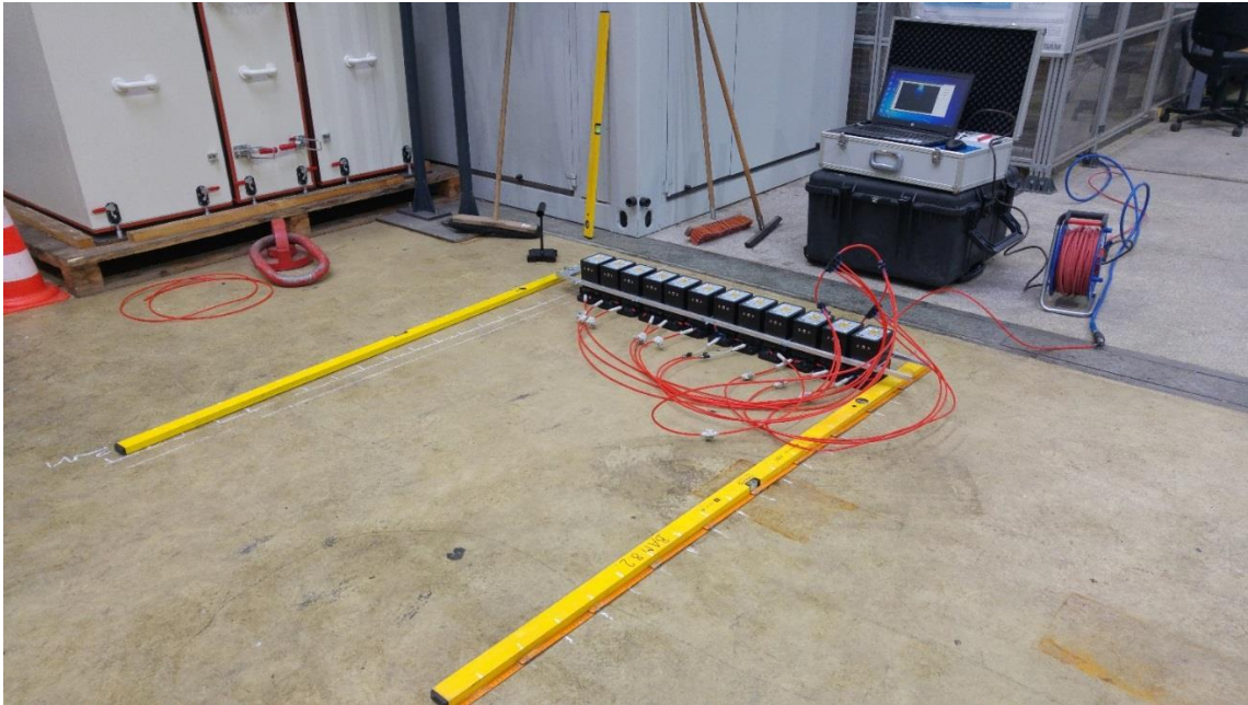
Abb. 4: Messungen mit dem LAUS-System auf dem Fundament des Fallturms.
