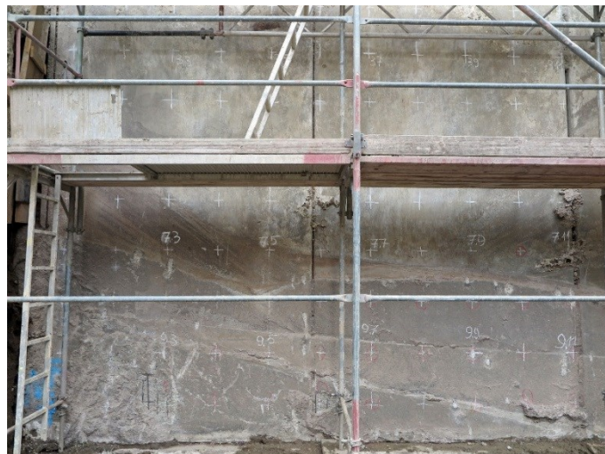
Bild 1. Messung Giebelwand: Ausschnitt des Messbereichs mit Gerüst und Messraster
