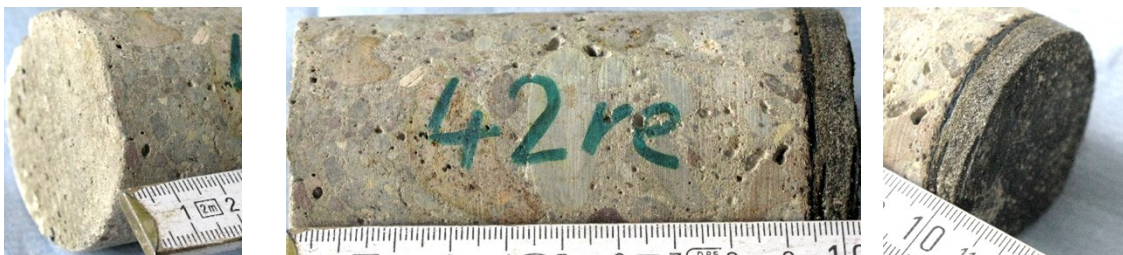
Bild 6. Messung Kuppel 1: Bohrkern mit rückseitiger Bitumschicht (Fotos: M. Krüger, MFPA Weimar)
