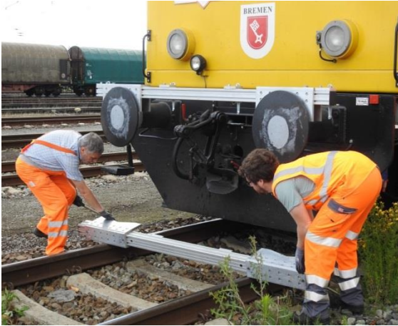
Abb. 2 Anbau der Haltevorrichtung an die Puffer einer GAF (Foto: DB E&C, UGG, I.TPU(T)).
