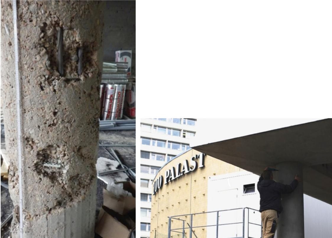
**Abb. 8: Minderfeste Stützen (links) sowie zerstörungsfreie Untersuchung an Stützen (rechts)**
