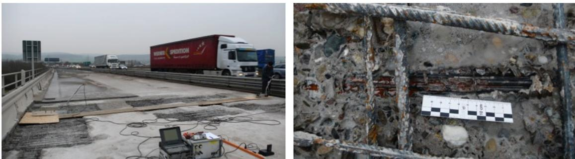
**Abb. 6: Streufeldmessung (links) sowie ermittelter Spannstahlbruch infolge Chlorideinwirkung (rechts)**
